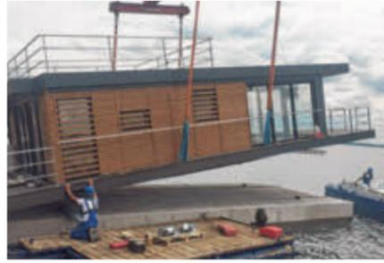
Montage eines „Floating 44“ auf ein Betonpontoon, wahlweise kann es auch mit Motor geordert werden
